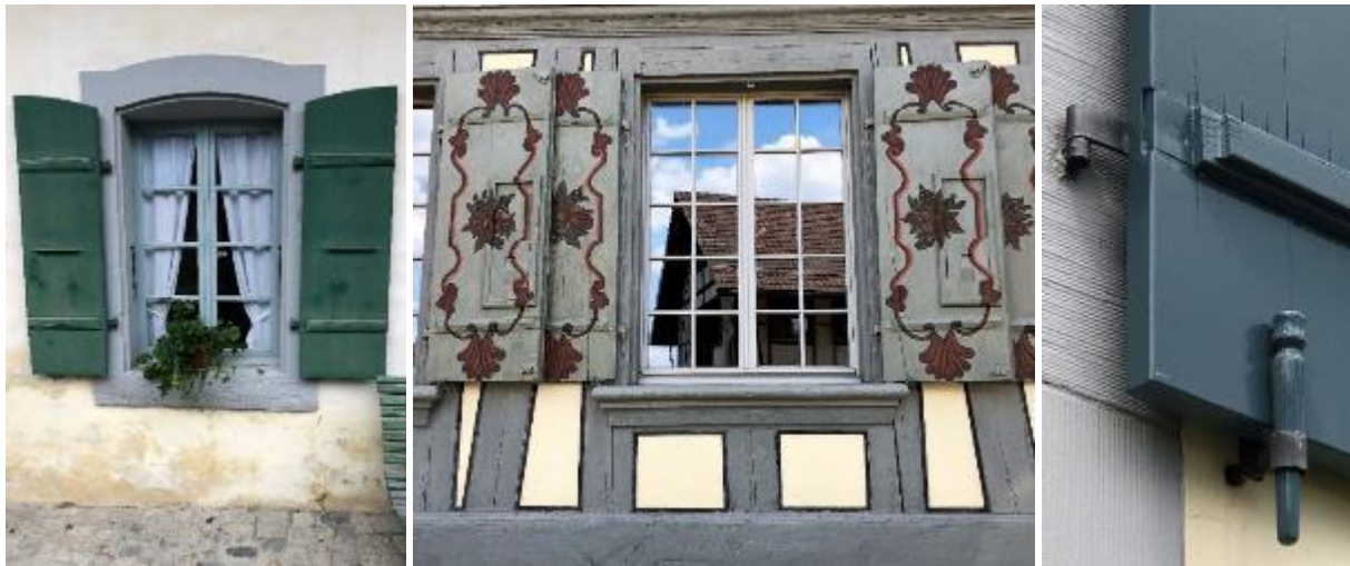
Abb. 37 bis 39: Gegratete Läden. Mittleres Foto: Speziell bei den jeweils rechten Läden sind die Schieber zum Öffnen, was man nur sehr selten sieht. Rechtes Foto: Anfangsstadium eines Schadens bei der Gratleiste.
