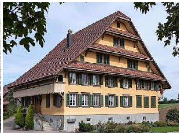
Abb. 330: Beinwil, 1776, Fassadenumgestaltung um 1900. EG und 1.OG mit Einzelfenstern und seitlichen Läden mit beweglichen Brettli, 2./3. OG die ursprünglichen Zwillingsfenster mit Läden mit beweglichen Brettli.
