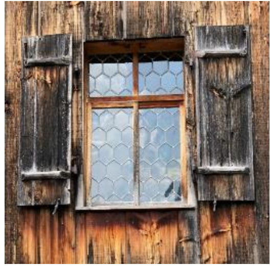
Abb. 180, 181: Haus Bethlehem, Schwyz, 1287. Fenstergestaltung nach einem Umbau im 18. Jh. mit Schiebeläden und Klappläden, unbehandelt. Die Zugladenkästen wurden 1989 nach Vorbild rekonstruiert.
