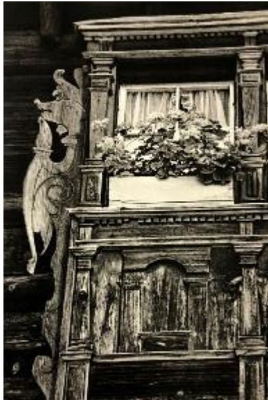
Abb. 160, 161: Haus Näf im Neckertal, Toggenburg, 17. Jh. Links Detail der Ziehläden mit Vertäferung, typische Renaissancedetails, rechts Hauptfassade.
