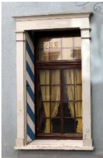
Abb. 26, 27: Spalettläden, Faltklappläden oder Persienne. Bild links Ausführung in Holz im offenen Zustand. Laden kann in der Leibung versorgt werden. Bild Mitte Ausführung in Metall im geschlossenen Zustand.
