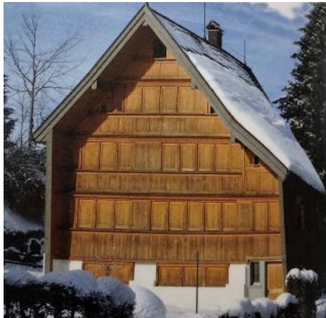
Abb. 277: Speicher, Wohnhaus, 19 Jh. mit ganzer Fassadeverkleidung mit geschlossenen Fallläden.
