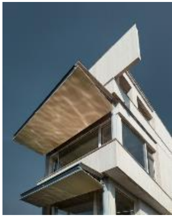
Abb. 266, 267: Ziel-Turm Ruderzentrum, Rotsee LU, 2013. Läden in Dreischicht-Massivholzplatten, kombiniert mit Stahl.
