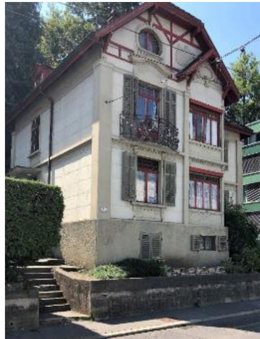
Abb. 214: Wohnhaus, Luzern, 1905. Stil-Pluralismus. Läden mit zwei Feldern. Querfries auf Höhe des Fensterkämpfers, bewegliche Lamellen.
