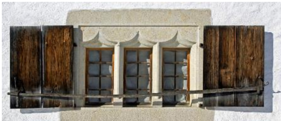
Abb. 32: Schlichter Bretterladen, als Ladenrückhalter ist eine Holzstange eingehängt.
