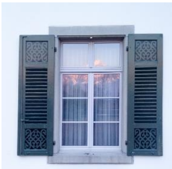
Abb. 20: Schwesternheim, Quarten SG, 1918. Haus im Heimatstil. Läden mit festen Lamellen und feinen Ornamenten.
