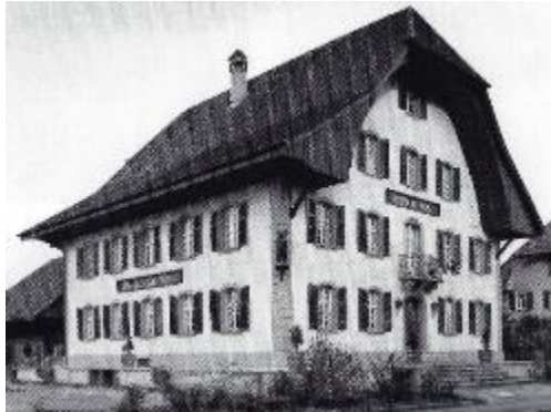
Abb. 327: Kölliken, 1777. Spätbarocker Bau mit Krüppelwalm und Ründi. Fenster Kreuzstock mit Stichbogen und Schlagläden.
