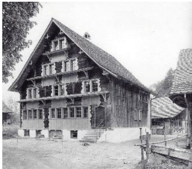
Abb. 302: Bauernhaus in Fischingen, 18 Jh. Ständerbau mit barocken Ziehläden unbehandelt, also von der Bauweise und Oberflächenbehandlung her eher die Ausnahme.
