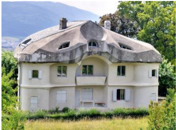
Abb. 248: Haus Duldeck, Areal Goetheanum, Dornach, 1915. Das Gebäude wurde nicht nach dem Neuen Bauen errichtet, jedoch in derselben Zeit, im plastisch-organischen Stil oder anthroposophischer Architektur. Feste Läden. Speziell ist, dass die Langbänder genau die Ladenbreite haben.
