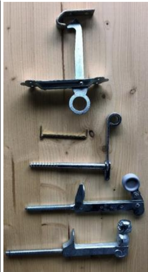
Abb. 123: Rückhalter, wie sie heute montiert werden. Von oben nach unten: Windfalle mit Schliessblech, Vorreiber mit Streicher, Standard-Rückhalter, gusseiserner Rückhalter.
