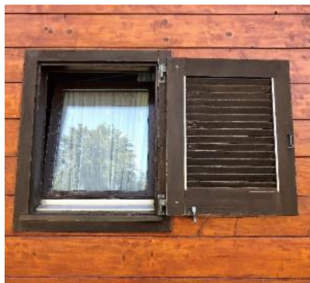
Abb. 78: Biedermeier-Wohnhaus in Schwyz, feste Lamellen zurückstehend aus neuerer Zeit. Abb. 79: Chalet, Fischbach LU, feste Lamellen zurückstehend. In den 1970er-, 1980er-Jahren wurde manchmal anstelle der Fräsungen im Fries eine entsprechende Aluleiste eingesetzt, was eine einfachere maschinelle Einrichtung des Jalousiebauer erlaubte.
