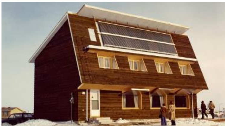
Abb. 3: Pionierhaus in Kanada mit wärmedämmten Fensterläden.
