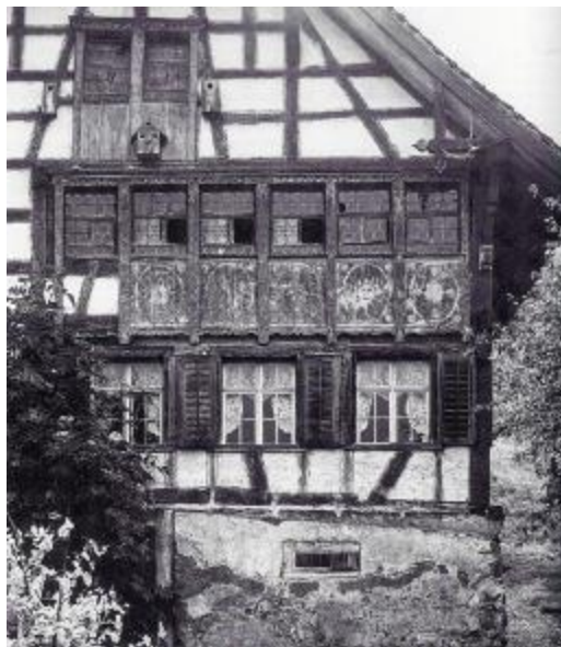
Abb. 301: Bauernhaus Tobel, Bild von 1911. EG neue Kreuzstöcke mit Klappläden, OG Reihenfenster mit Zugläden und Malereien.
