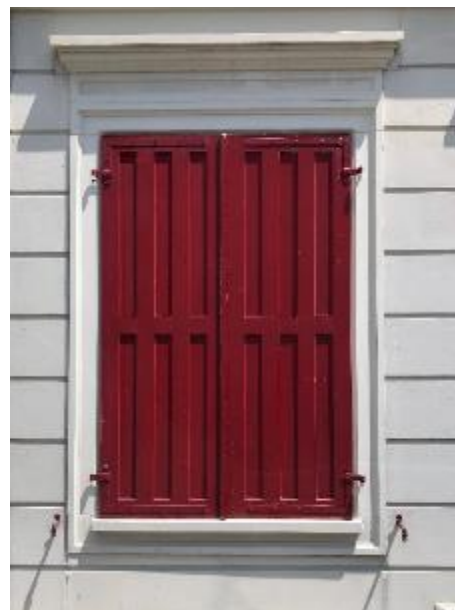
Abb. 64: Gasthaus im Historismus, Willisau. Gerade Füllungen als Zierelement. Aussergewöhnlich ist, dass Füllungen und Fries gleich breit sind.
