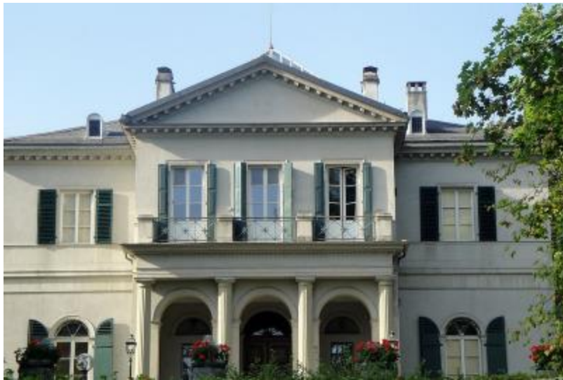
Abb. 186: Villa Morillon, Wabern, Bern, 1834. Zeittypische Front mit drei unterschiedlichen Fensterläden. Oben links und rechts mit vorstehenden Lamellen, oben in der Mitte Fallläden mit je drei überschobenen Füllungen, unten links und rechts feste Läden mit Gratleisten und im Bogen Einsatz mit festen Lamellen.
