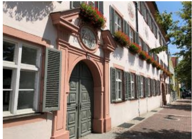
Abb. 76: Detail eines Ladens im Schweizerhausstil mit bündigen Lamellen. Speziell: Rückhalter mit Stossriegel. In der Leibung auf Rahmen montiert wie in Deutschland weit verbreitet. Abb. 77: Rathaus Erding. Läden mit bündigen Lamellen.
