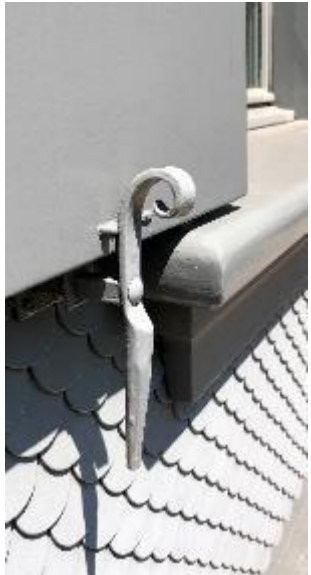
Abb. 116 bis 118: Links Vorreiber geschmiedet, Mitte Holzsetzholz, rechts Metallstift verkettelt.
