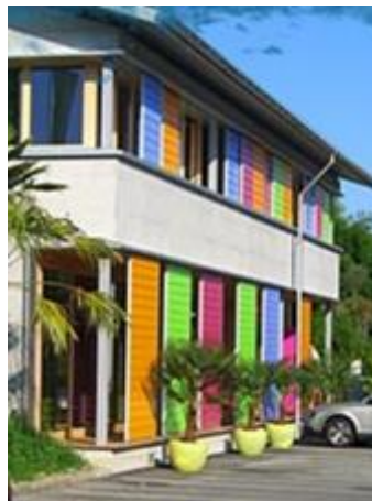
Abb. 270: Geschäftshaus Caribbean Village, Nottwil, 2009. Schiebeläden in Kombination Holz mit Alurahmen.
