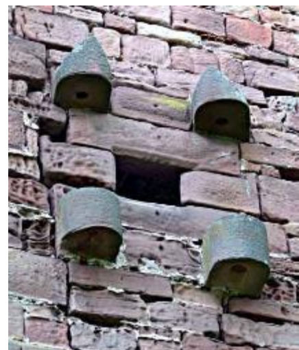
Abb.137: Burg Landsberg, Elsass, erhaltener Teil eines Drehzapfenbands.
