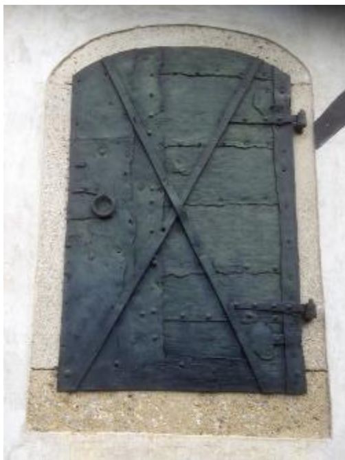
Abb. 198: Gefertigt nach Machart in der Gotik. Klumpengeschmiedet mit zum Teil ausgeschmiedetem Rand als Verstärkung, ursprünglichem Schippenband und späteren Langbändern.
