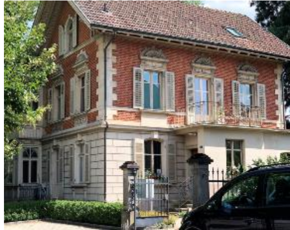
Abb. 204: Villa, 1890, Langenthal. Unterschiedliche Läden im EG (fixe bündige Lamellen) und in den Obergeschossen (bewegliche Lamellen).
