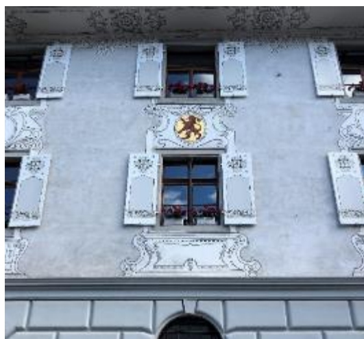
Abb. 35: Rathaus, Willisau, 1720. Läden mit Malerei, unten und oben mit bündigen Anfassleisten, welche übermalt sind.
