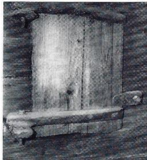
Abb. 92: Mollis, Schlagladen im Dachgeschoss, alle Beschläge in Holz.
