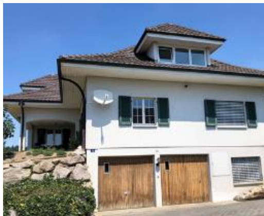
Abb. 253: EFH, Fischbach LU, 1980er-Jahre im Landhausstil. Läden kombiniert mit Rafflamelle.
