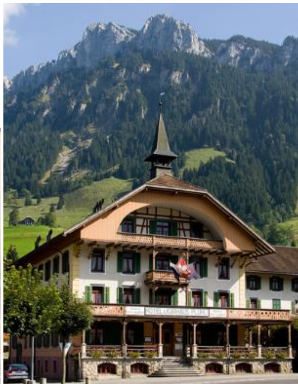
Abb. 210: Kurhaus Flüfli, 1900. Bauzeuge der Blütezeit der Berghotellerie. Läden zweifeldrig mit beweglichen Lamellen.
