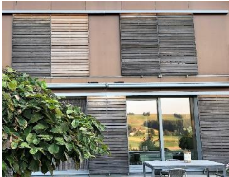
Abb. 373: Wohnhaus, Fischbach LU, 2010. Moderne Schiebeläden in Lärche/Alu. Je nach Position/Schutz mit unterschiedlicher Vergrauung. Das Bild wurde aufgenommen nach acht Jahren an der Süd-West-Fassade, relativ nebelarm, auf 663 m ü. M.
