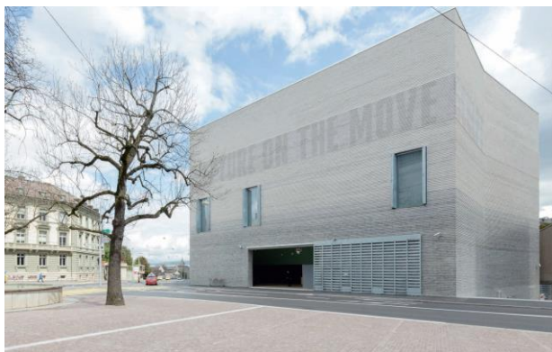
Abb. 259, 260: Kunstmuseum Basel, 2016, Architektur Christ & Gantenbein, Faltschiebeläden in Stahl feuerverzinkt.
