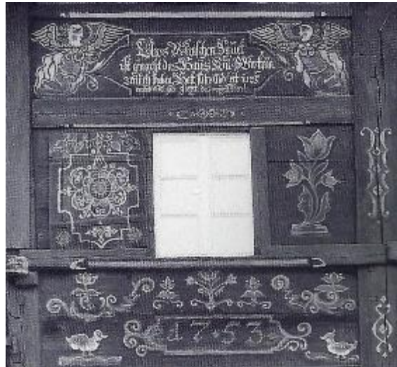
Abb. 306, 307: Gujerhaus in Uster, 1660/1740. Repräsentative Fassade mit Malerei von 1753, im EG Falläden, im OG seitliche Schiebeläden. Foto rechts Ausschnitt über der Haustüre.
