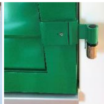
Abb. 95 bis 97: Diverse Bänder mit Kloben. Links Stützkloben mit Langband im barocken Stil, Mitte Futterkloben mit Winkelband (heute Standardband, schön ausgemittelt auf dem Rahmenfries), rechts Aluläden mit verstellbarem Band.
