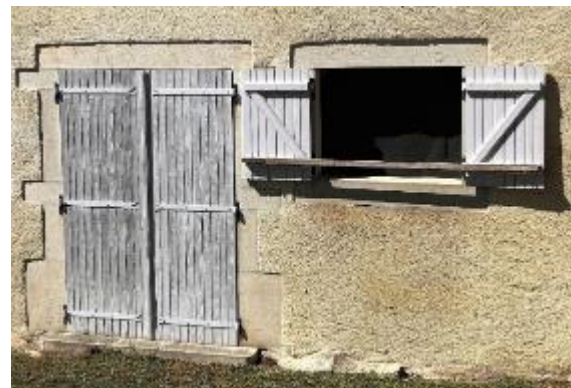
Abb. 31: Offenes und geschlossenes Licht Läden mit aufgedoppelten, geschraubten Latten in Z-Form.
