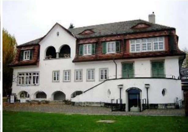
Abb. 212: Villa Sunneschy, Stäfa, 1908. Schlichter Jugendstil. Balkon mit Fensterläden mit Jugendstileinfluss, Läden DG traditionell mit beweglichen Lamellen.
