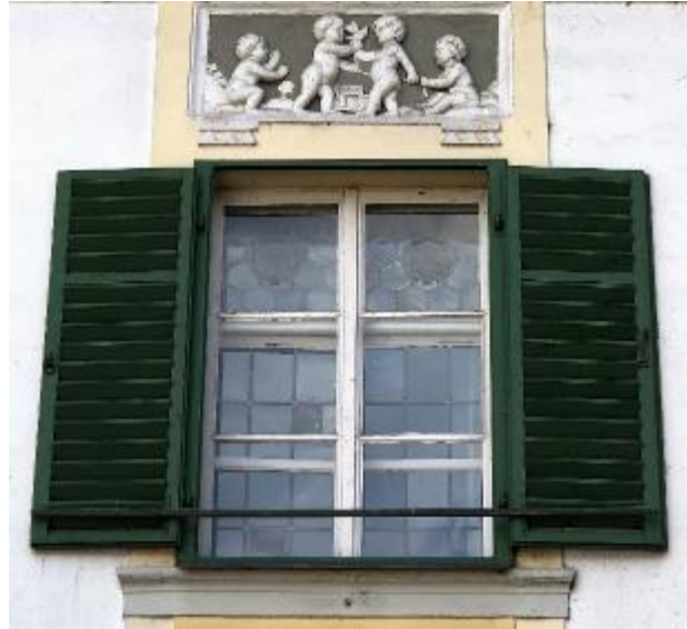
Abb. 115: Gasthof zur Post, Oberzell bei Passau D, erbaut im klassizistischen Stil. Quere Holzlatte als Rückhalter.
