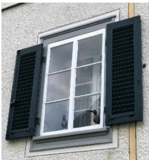
Abb. 78: Biedermeier-Wohnhaus in Schwyz, feste Lamellen zurückstehend aus neuerer Zeit. Abb. 79: Chalet, Fischbach LU, feste Lamellen zurückstehend. In den 1970er-, 1980er-Jahren wurde manchmal anstelle der Fräsungen im Fries eine entsprechende Aluleiste eingesetzt, was eine einfachere maschinelle Einrichtung des Jalousiebauer erlaubte.
