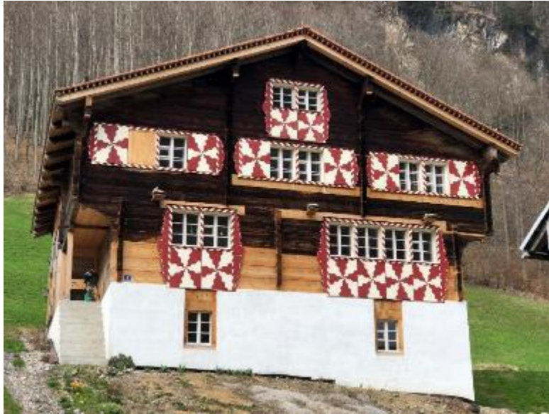
Abb. 10: Wyssighaus Isenthal UR, erbaut 1790, versetzt 2013/2014. Läden nach alten Mustern rekonstruiert.
