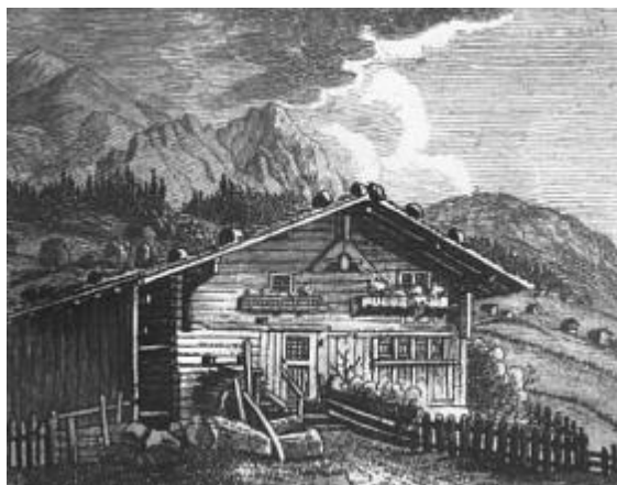
Abb. 292: Zwinglihaus, Malerei, 18. Jh. Links der Türe Luken, rechts Fensterwagen vierteilig mit noch deutlich kleineren Fenstern. Oberhalb der Türe links Fenster ohne Läden, rechts mit Zugläden.
