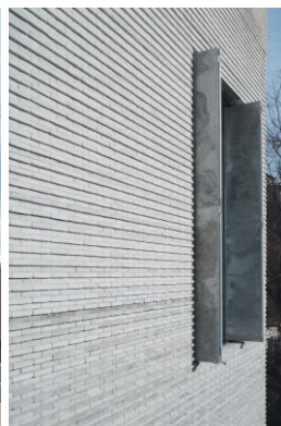
Abb. 259, 260: Kunstmuseum Basel, 2016, Architektur Christ & Gantenbein, Faltschiebeläden in Stahl feuerverzinkt.
