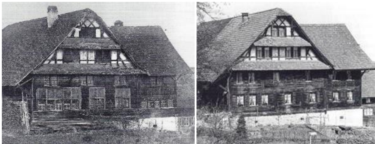
Abb. 331, 332: Villmergen, 1736. Veränderung der Fenstersituation. Links mit Zwillingsfenstern und Reihenfenstern mit Fallläden, Aufnahme um 1900. Rechts nach Veränderung mit Einzelfenstern, Anfangs 20. Jh.
