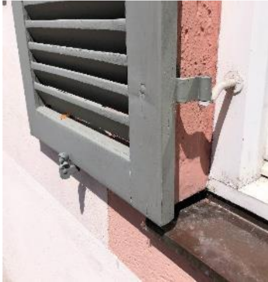
Abb. 98: Anschlag zwischen Leibung auf Blendrahmen mit passendem Kloben (oft verwendet in Deutschland).
