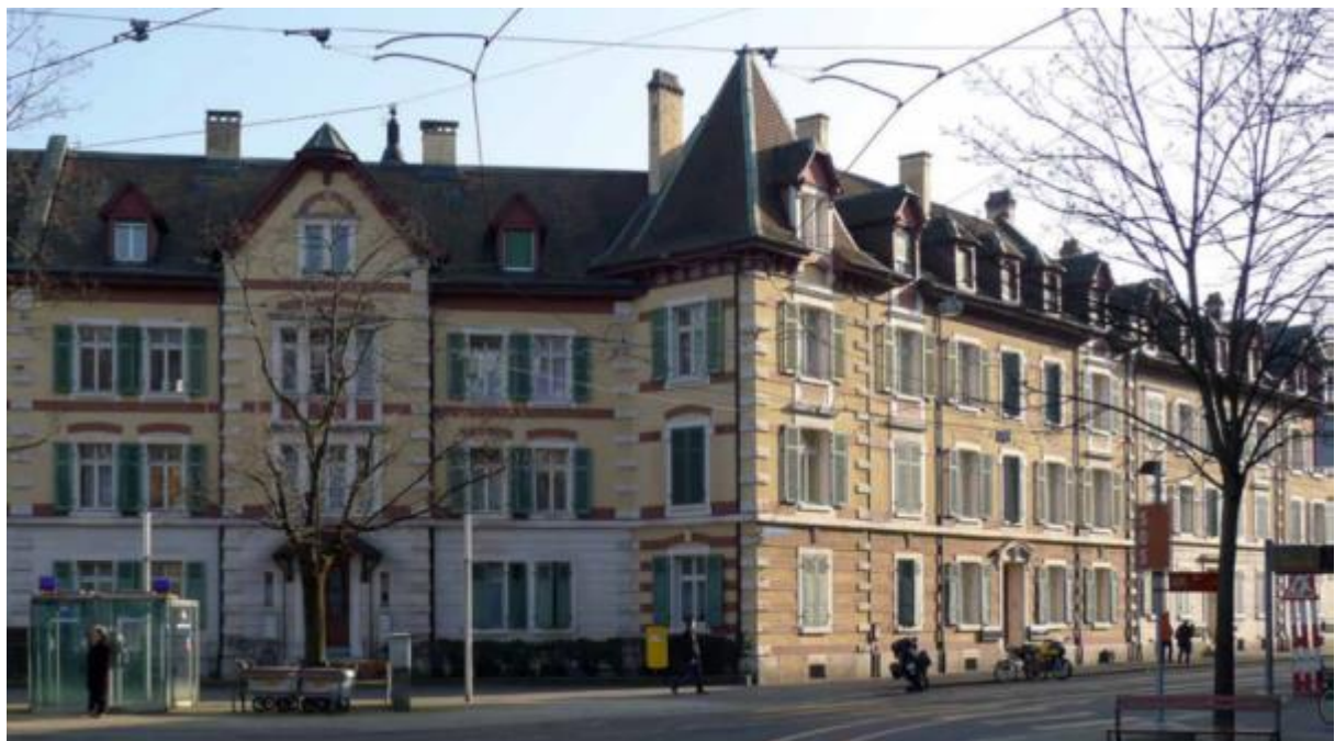
Abb. 202: Genossenschaftssiedlung in Basel, 1891. Fensterläden im Erdgeschoss unten mit Füllung, oben Lüftungsschlitze, im 2. und 3. OG feste Lamellen. Farblich gut assortiert, beige für Putze, Rot für Sichtbacksteine, grün für Läden.
