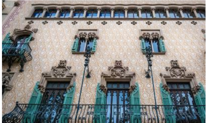
Abb. 216: Casa Amatller, Barcelona, umgebaut 1900 im katalanischen Jugendstil Modernisme. Läden als zusätzliches Fassadenschmuck-Element. Bei geschlossenen Läden sind die Oblichtfenster nicht beschattet.
