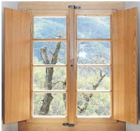
Abb. 103: Innenladen in Kastanienholz, als Verschluss in der Mitte ein Holzriegel zum Drehen.
