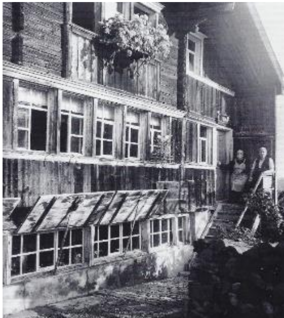
Abb. 276: Speicher AR, Kohlhalde, Bild aus dem Jahr 1956. Im Webkeller Läden aufgeklappt, im EG durchgehende Verkleidung, im OG Ladenkästen nur im Bereich der Fenster.
