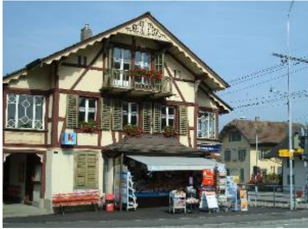
Abb. 207: Bahnstation, Aarwangen, 1907. Riegelbau mit zahlreichen Zierelementen im Schweizerhaus-Stil.
