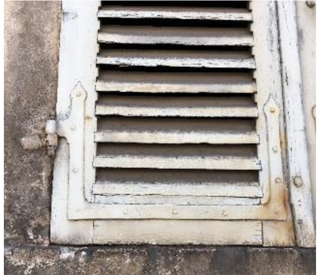
Abb. 99: Ladenband in U-Form, genau auf Breite des Ladens angefertigt. Burgund, Frankreich.
