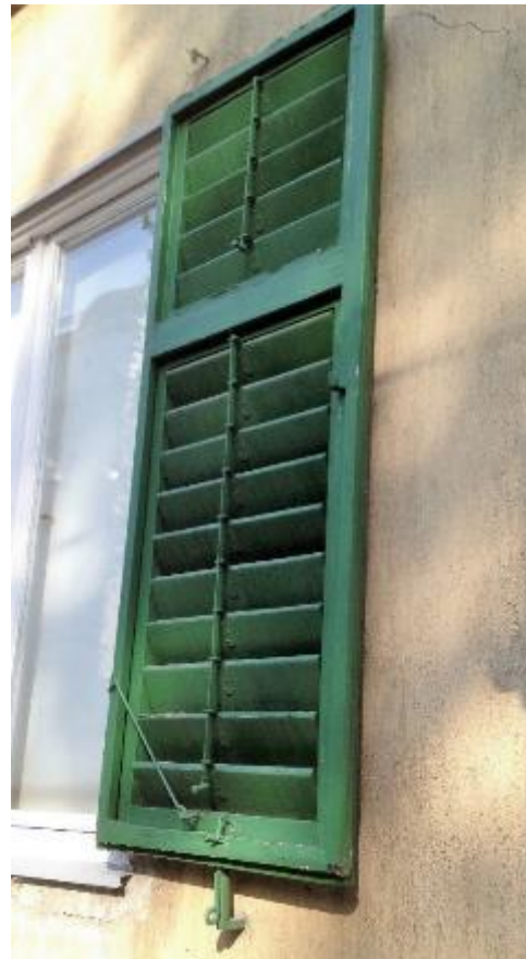
Abb. 183: Laden mit beweglichen Lamellen, zwei Felder, unteres Feld mit Aussteller. Fixierung mittels Sperrstange und Vorreiber.
