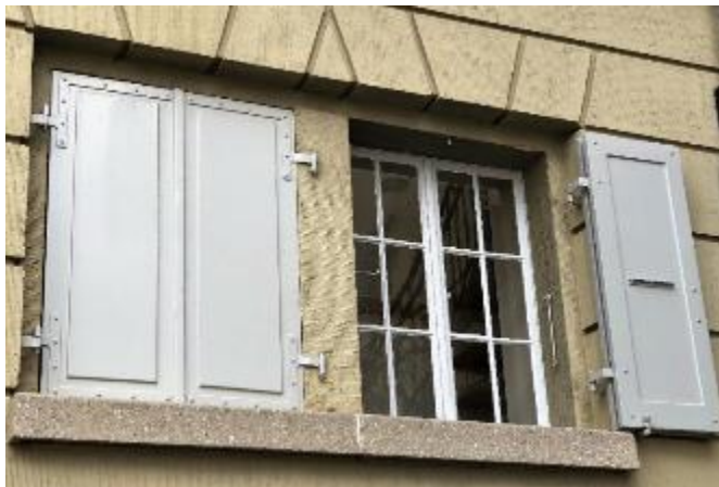
Abb. 68: Überschobene Füllungen, im geschlossenen Zustand vorstehend, im offenen Zustand zurückstehend.
