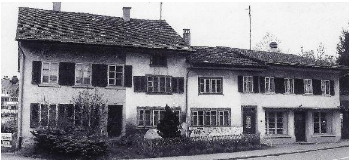
Abb. 308: «Modernisierter» Flarz in Kempten/Wetzikon. Links aufgestockt mit Steildach, linkes und rechtes Haus mit neuer Fenstereinteilung und Schlagläden, mittlere zwei Häuser noch mit Reihenfenstern, jedoch ohne Läden.
