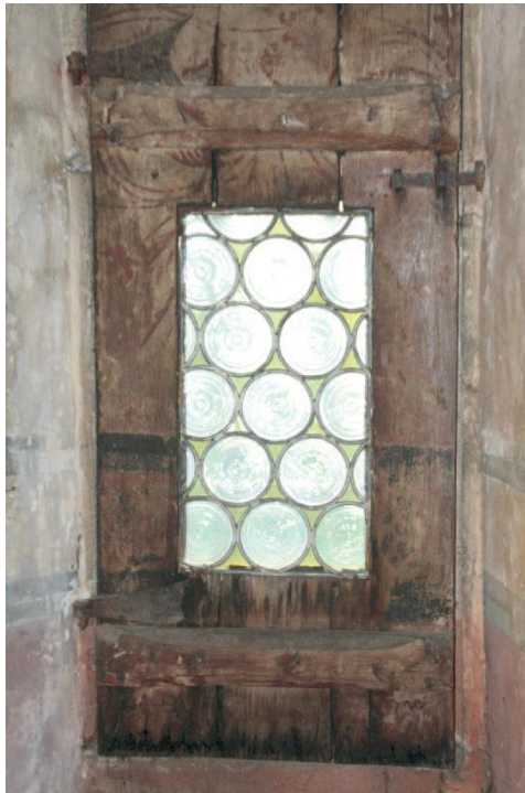
Abb. 138: Fritzlärer Dom, in Situ, vor 1500. Fensterladen in Brettkonstruktion mit aufgenagelten Querleisten und verglastem Lichtausschnitt (Glas aus neuerer Zeit).
