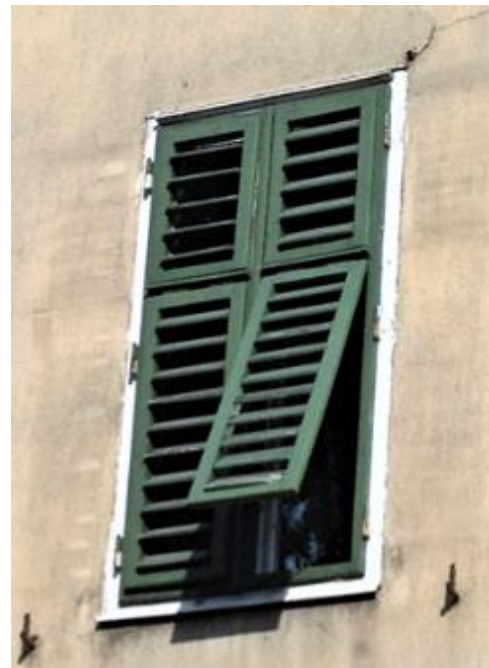
Abb. 185: Läden mit beweglichen Brettli und Ausstellladen.
