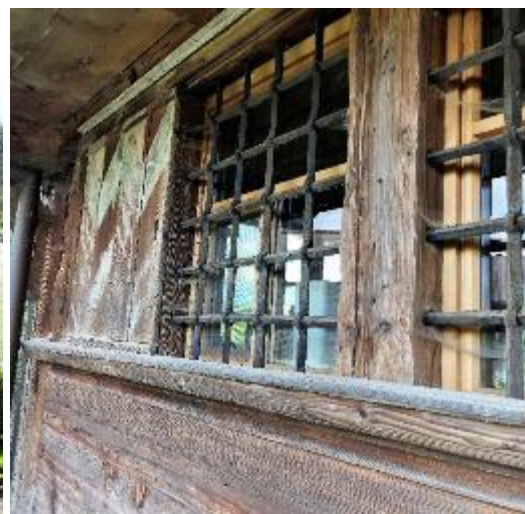
Abb. 336, 337: Bauernhaus Rüt matt, Ruswil, 1758. Links im EG der Giebfassade hat es Fallläden, in den Obergeschossen horizontale Schiebeläden. Rechts ursprüngliche Schiebeläden auf der Traufseite, welche geschützt unter der Laube sind.
