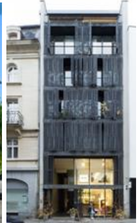
Abb. 271: Wohn- und Geschäftshaus in Basel, 1993, Herzog & de Meuron. Faltschiebeläden in Gusseisen.
