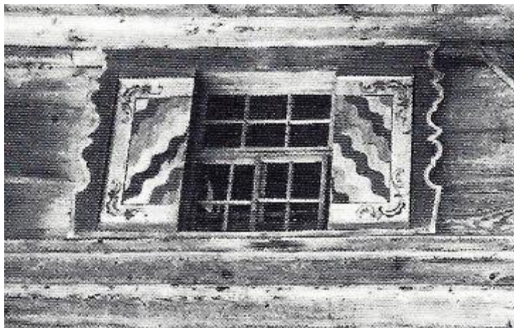
Abb. 338: Bauernhaus Ober-Schongau, um 1750. Einfeldriges Fenster mit zwei Läden, Verkleidungen geschweift.
