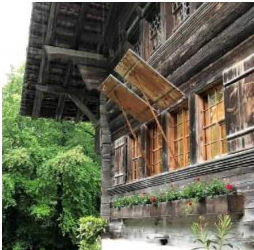
Abb. 353: Haus Matten 1570, Ballenberg. Vierteiliges Fenster, links/rechts Schlagläden, Mitte Klappläden.
