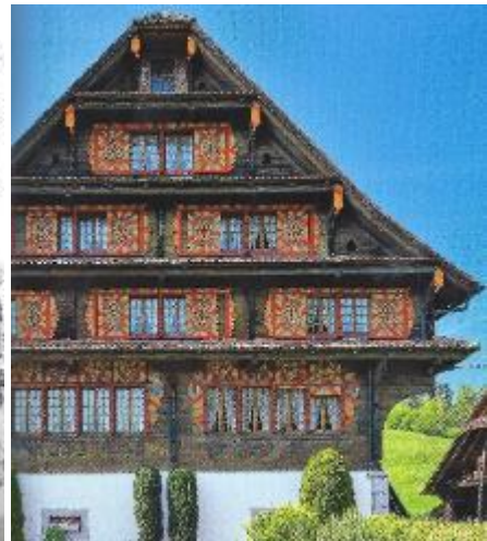
Abb. 334: Meierskappel, 1756, renoviert 1985. Fenster und Läden rekonstruiert nach alten, gefunden Mustern. EG Fallläden, OG Schiebeläden.
