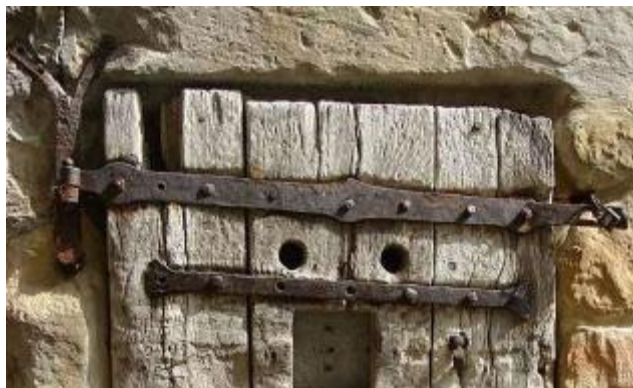
Abb. 30: Detail eines Ladens, bei dem das Holz mit Langbändern zusammengehalten wird. Das zweite, geschmiedete Flacheisen ist üblicherweise nicht vorhanden.
