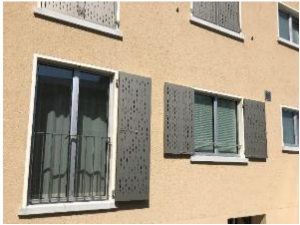
Abb. 264, 265: Genossenschaftliches Wohnen, Luzern. Links Teil Neubau, 36 Wohnungen mit Aluschiebeläden. Rechts renovierte Mehrfamilienhäuser mit 98 Wohnungen in unmittelbarer Nähe, aus den 1940er- und 1950er-Jahren. Die alten Holzläden wurden durch Aluläden mit gleichem Design wie im Neubau ersetzt.
