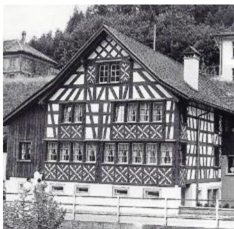
Abb. 303: Wohnhaus Fischingen. Giebelbetonte Fassade mit Ziehläden und geflammt Malerei.
