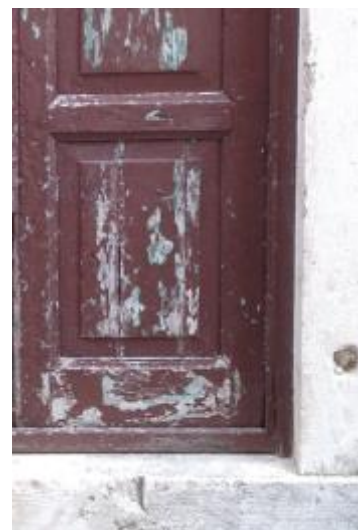
Abb. 56: Ladendetail, gestemmt mit Beizapfen auf Gehrung.
