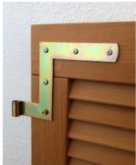
Abb. 59: Ansicht Ecke. Feste Lamellen mit gerundeten Kanten, wodurch eine «offene» Fuge entsteht.
