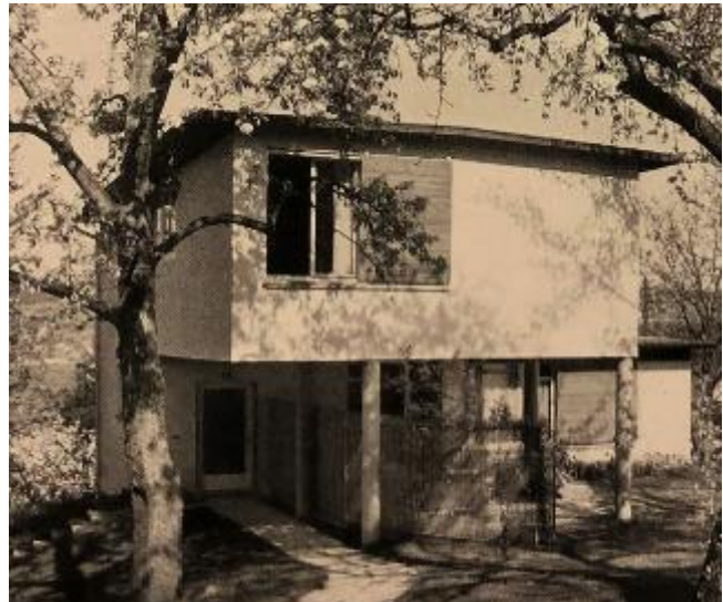
Abb. 242: Wohnhaus in Rüslikon, 1937, Architekt R. Steiger. Schiebeläden, wie sie auch heute wieder hochaktuell sind.
