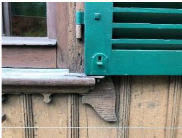
Abb. 76: Detail eines Ladens im Schweizerhausstil mit bündigen Lamellen. Speziell: Rückhalter mit Stossriegel. In der Leibung auf Rahmen montiert wie in Deutschland weit verbreitet. Abb. 77: Rathaus Erding. Läden mit bündigen Lamellen.
