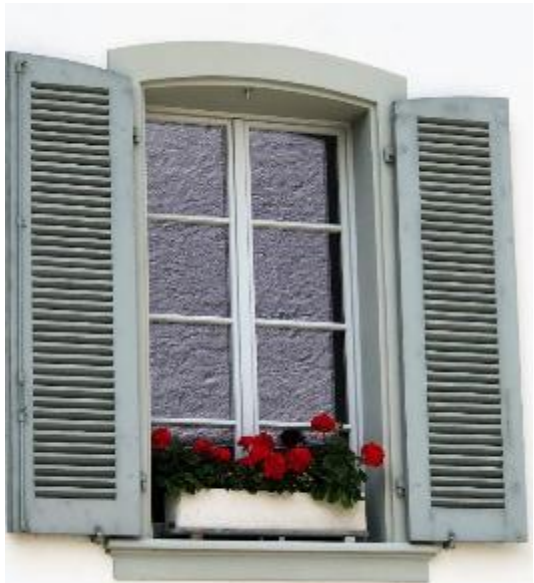
Abb. 178, 179: Pfarrhaus, Willisau, Fensterläden im 1./2. OG mit festen, bündigen Brettli, ähnliche könnten bei der Fassadengestaltung um 1800 schon eingebaut worden sein. Mansardendach mit gestemmtten Läden mit Füllungen.
