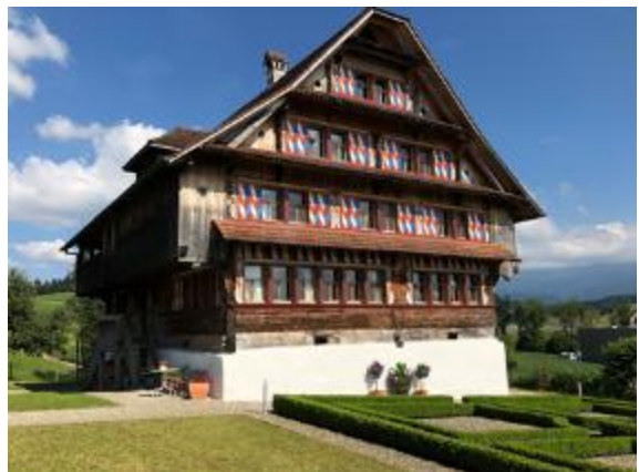
Abb. 193, 194: Haus Rüt matt, Ruswil. Beispiel einer Veränderung der Fenstereinteilung. Links mit den Veränderungen der Biedermeierzeit mit Einzelfenstern und Drehläden beidseits der Fenster, rechts nach der Renovation mit ursprünglichen barocken Reihenfenstern und Schiebe- beziehungsweise Zugläden.
