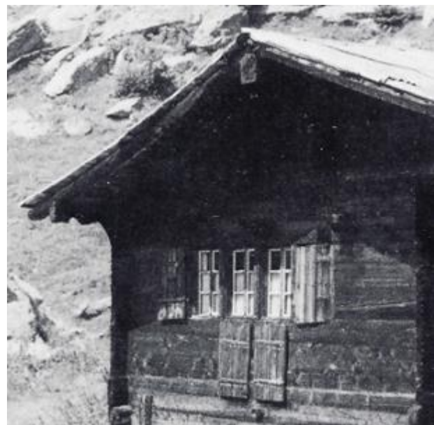
Abb. 366: Blatten Fafleralp. Seltene Öffnungsart mit seitlichen Schlagläden und Klappläden gegen unten in der Mitte.
