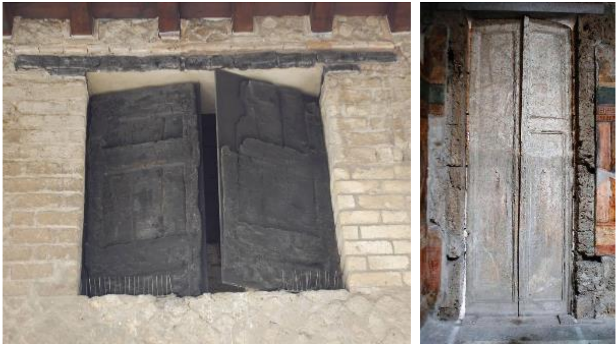
Abb. 131, 132: Überreste eines abgebrochenen Ladens nach dem Ausbruch des Vesuvs im Jahr 79 n. Chr.. Links Herculaneum, Fensterläden in Rahmenkonstruktion und Füllungen. Rechts Pompeji, filigran ausgeführte Türe.
