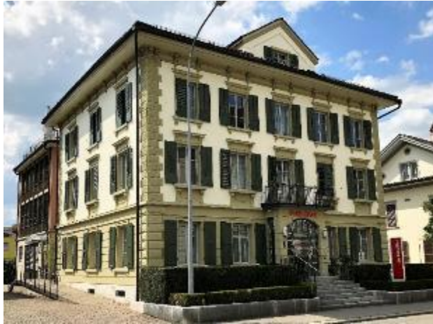
Abb. 203: Wohn- und Geschäftshaus, 1890, Langenthal. Spätklassizistischer Bau mit historistisch gestalteter Fassade. Läden EG mit je zwei geschlossenen Füllungen, Obergeschoss mit zwei Feldern und beweglichen Lamellen.
