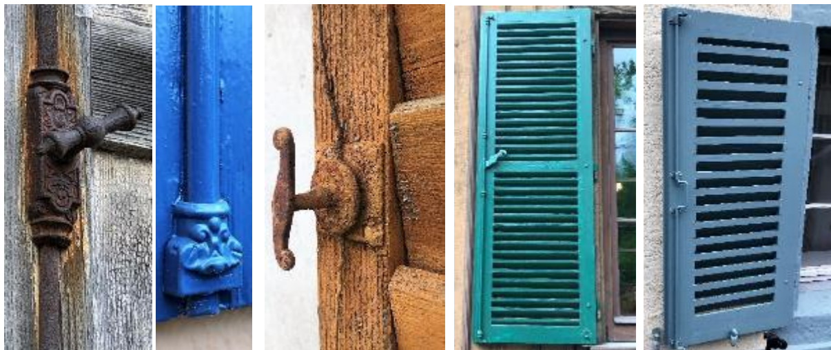
Abb. 109, 110: Griff und Führung, unten je eine Kremone (Baskülverschluss).
