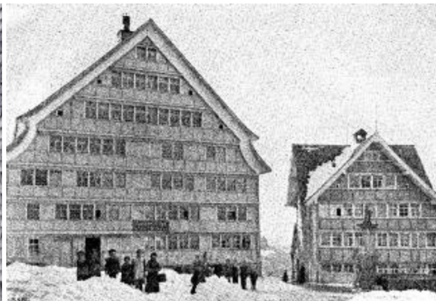
Abb. 282: Wohn- und Geschäftshaus in Trogen, Aufnahme um 1900. Bei repräsentativen Bauten waren die Fassaden oft deckend grülich gestrichen.
