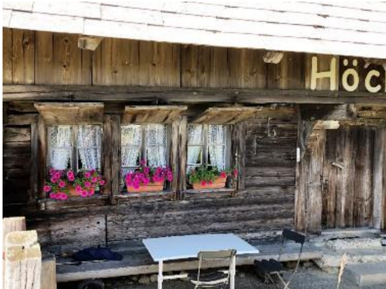
Abb. 24: Alp Hochänzi beim Napf. Klappläden bei Reihenfenstern, welche im Winter solid geschlossen werden können.
