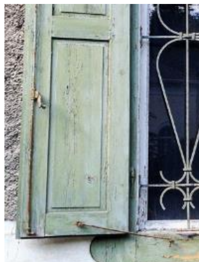
Abb. 57: Ladendetail, gestemmt mit Beizapfen auf Contrefacon.
