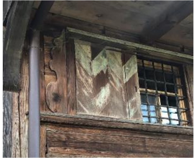
Abb. 6, 7: Bauernhaus Rützmatt, Ruswil, erbaut 1758. Die seitlichen Schiebeläden wurden nach einem unter der Konstruktion verbauten ursprünglichen Laden (rechts) behandelt. Man beachte die geschweiften Verkleidungen seitlich und die Verkleidung oben mit den passenden Malereien.
