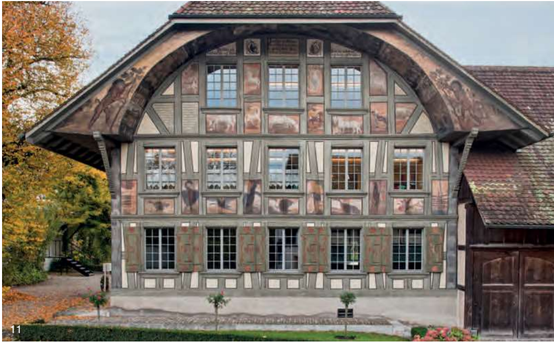
11— «Tierlihuus», Aarwangen, 1767. Die reiche Bemalung der Fassade und der Fensterläden im EG wird durch die Nordausrichtung und das Vordach geschützt. Foto: Beat Schertenleib
